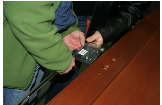
Montaż zamka do skrzydła drzwiowego. Fot. Zakład Stolarki Budowlanej CAL
